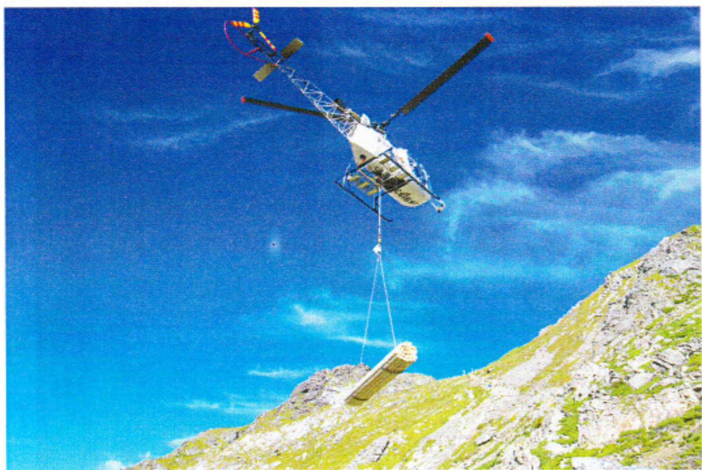
登山道の土砂止めを現地の状況に応じて作る。準備資材は約三十五t、荷上げは九月十一日にヘリコプターでトラバース分岐へ揚げた。急入りに現地を調査し、シユミレーション後、一度下山して体制を整えることにした。
